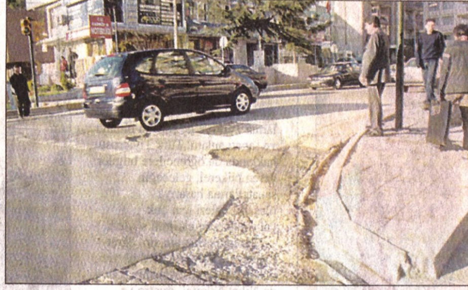
Kar yağışının ardından yollarda meydana gelen çukurlar, Kadıköy Belediye ekipleri tarafından süratle onarılıyor....
